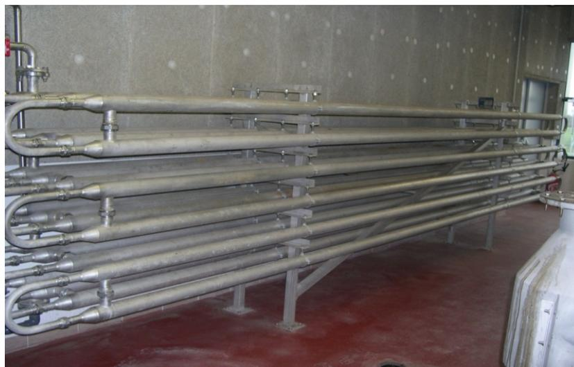
Poiché, però, il bilancio termico varia a seconda delle stagioni al variare della temperatura dell'acqua di rete, delle dispersioni termiche del digestore ecc., si prevede la messa in opera di un sistema di controllo che, a partire dalla temperatura in digestione, regoli la potenzialità dello scambio termico, variando la portata dell'acqua circolante nello scambiatore, fino ad escluderlo del tutto, quando necessario.
