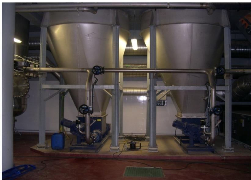
La portata della pompa si calcola in modo da poter alimentare tutto il fango in arrivo durante un ciclo di idrolisi durante i due brevi periodi destinati in ogni ciclo al caricamento reattori. Il trattamento di idrolisi termica viene articolato su due serbatoi verticali, operanti in batch.
